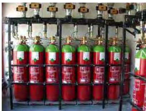
Impianto a gas chimici (es.: HFC-23)
