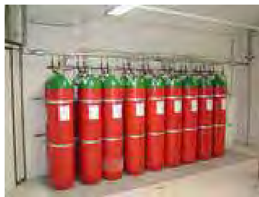
Impianto a gas inerti (es.: argon IG-02)
