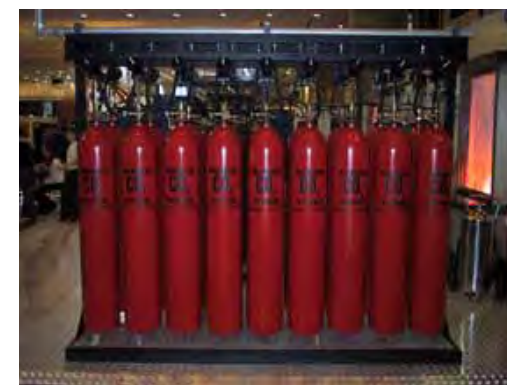
Impianto ad anidride carbonica
